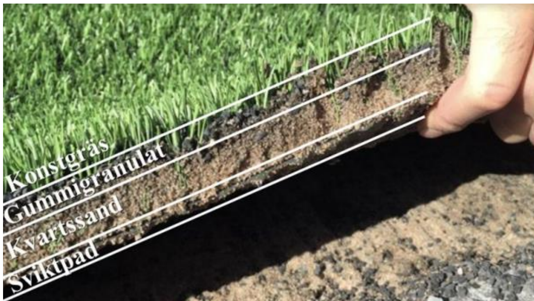
Figur 3-3. Konstgräsplanens system med lager. (Bildkälla: https://uu.diva-portal.org/smash/get/diva2:1112279/FULLTEXT02.pdf ).
