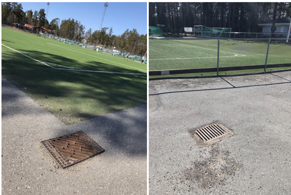
Figur 3-6. Exempel på två dagvattenbrunnar med granulatfälla på Brantbrinks IP. (Foto från platsbesök av Lovisa Ericsson)
