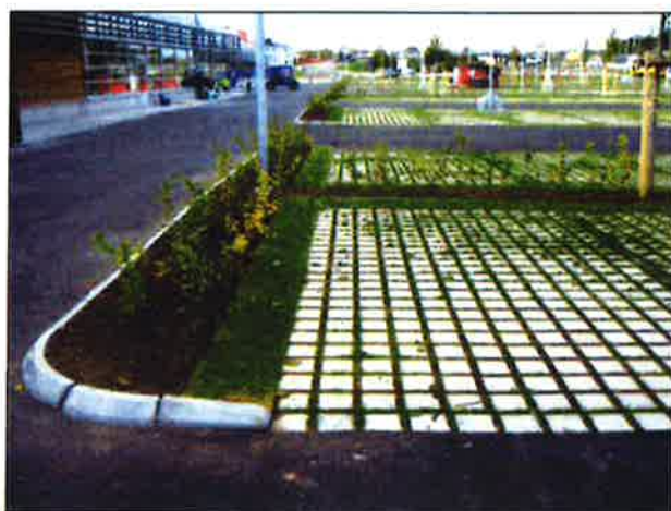
Parkeringsyta med genomsläpplig beläggning
