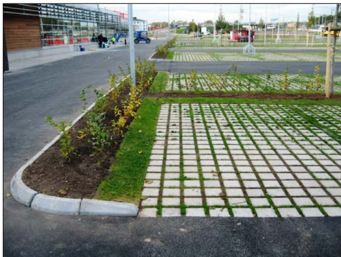
Parkeringsyta med genomsläpplig beläggning
