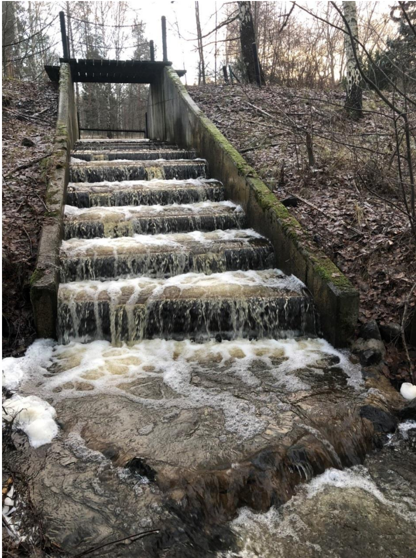
Nygjord fisktrappa nedströms branddamm i Harbrobäcken, december 2018.
