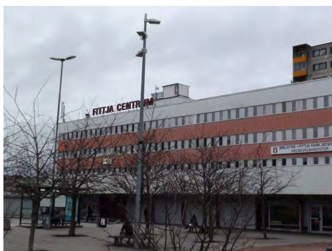
Vy från torget mot centrum och tunnelbanestation
