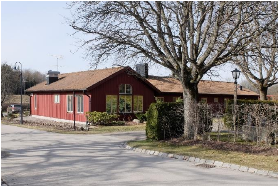
Figur 14. Den befintliga personalbyggnaden. Foto Tyréns.
