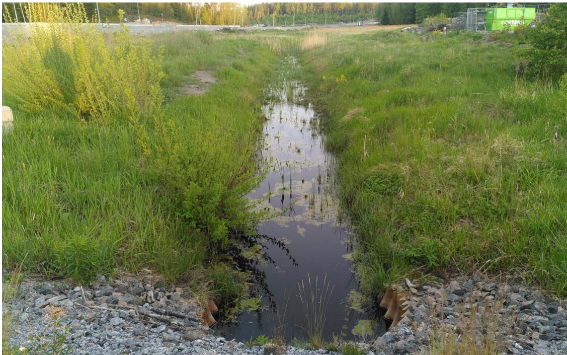
Figur 5. Den södra delen av det stora diket (objekt 3) där vatten rinner genom en kulvert. Här är det mer solbelyst och vegetationsrikt än i den norra delen.
