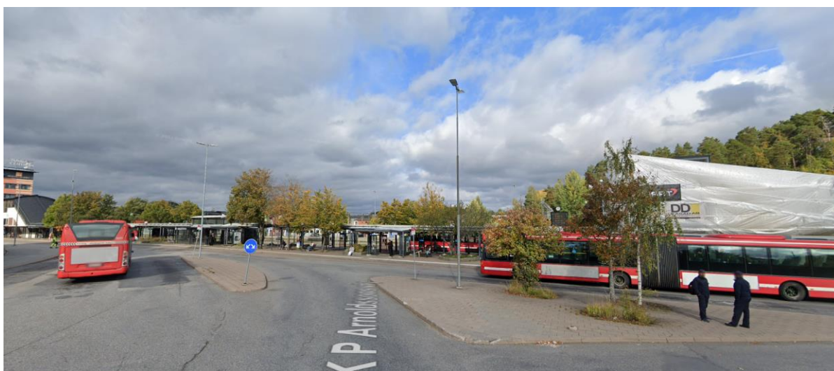
Figur 9. Tumbas bussterminal och pendeltågsstation. Källa: Google maps (2022).
