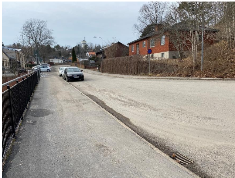
Figur 8. Allévägen med vändplats intill äldreboende. Foto: Ramboll.
