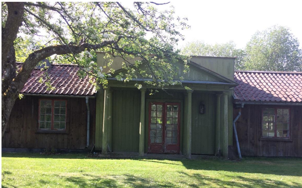
Bild 20: Orangeriets norra fasad (foto Sofia Didrik)
