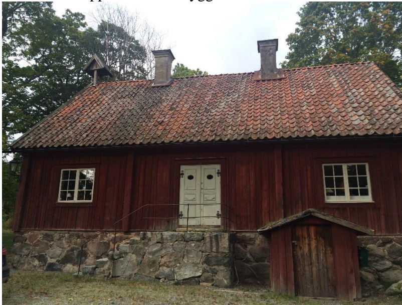
Bild 19: Klockhusets södra fasad (foto Sofia Didrik)
