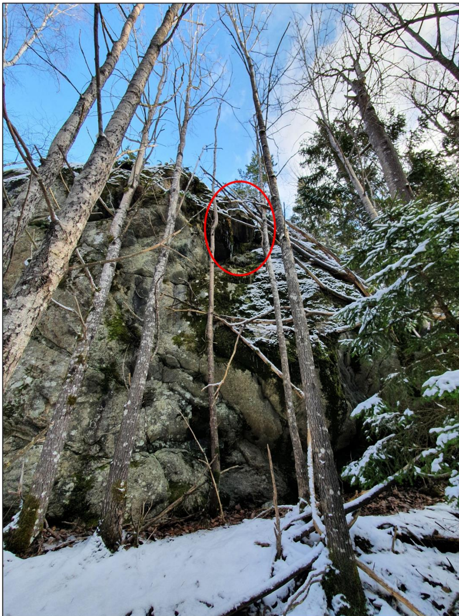
Figur 13. Åtgärd på släntdel D. Block som ska rensas är inringat med rött.
