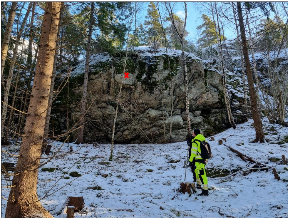
Figur 12. Förstärkningsåtgärd på släntdel C. Röda X visar bultplacering.
