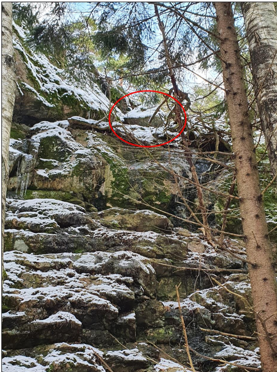
Figur 11. Åtgärd på släntdel B. Sten som ska rensas är inringad med rött.
