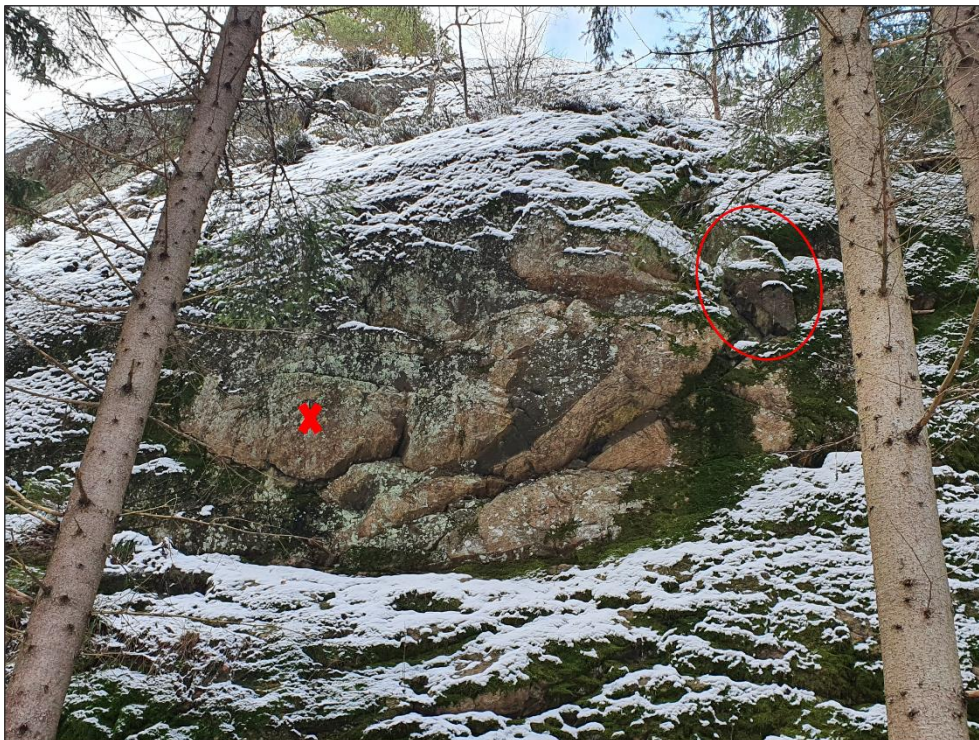
Figur 9. Förstärkningsåtgärd på släntdel B. Röda X visar bultplacering. Blocket som ska rensas är inringat med rött.
