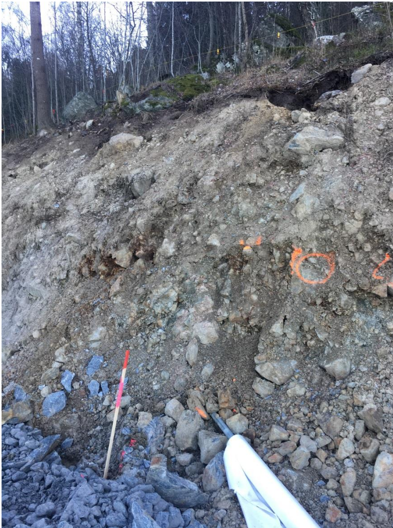
Figur 4: Block och sten synliga vid pågående schakt vid 18T02.
