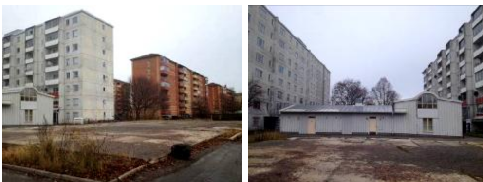
Befintlig bostadsbebyggelse i åttavåningar.
