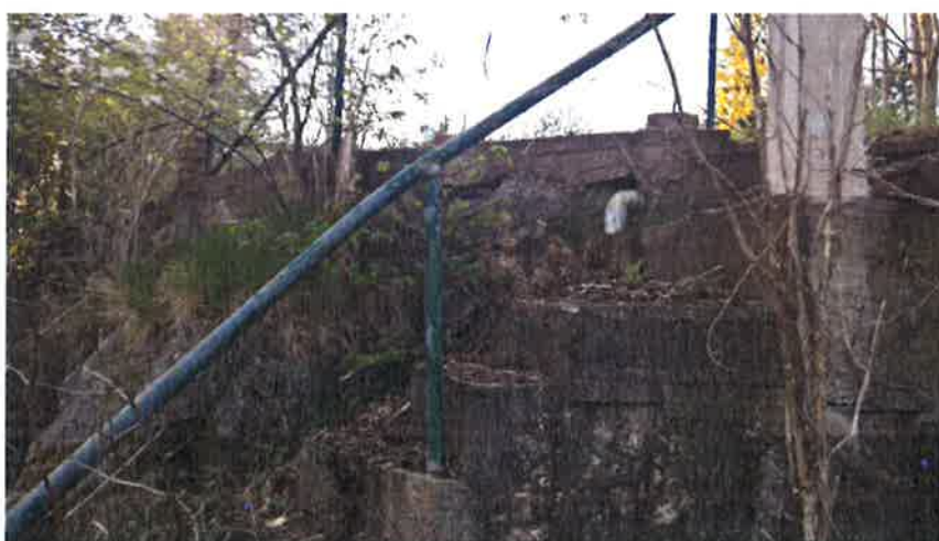
Foto 8 – Berg i dagen och befintlig stentrappa
