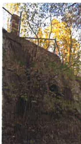
Foto 7 – Berg i dagen och befintlig terrassmur
