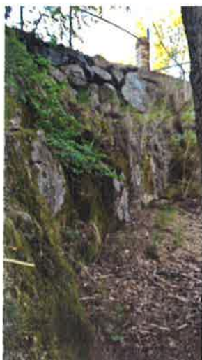
Foto 6 – Berg i dagen och befintlig terrassmur
