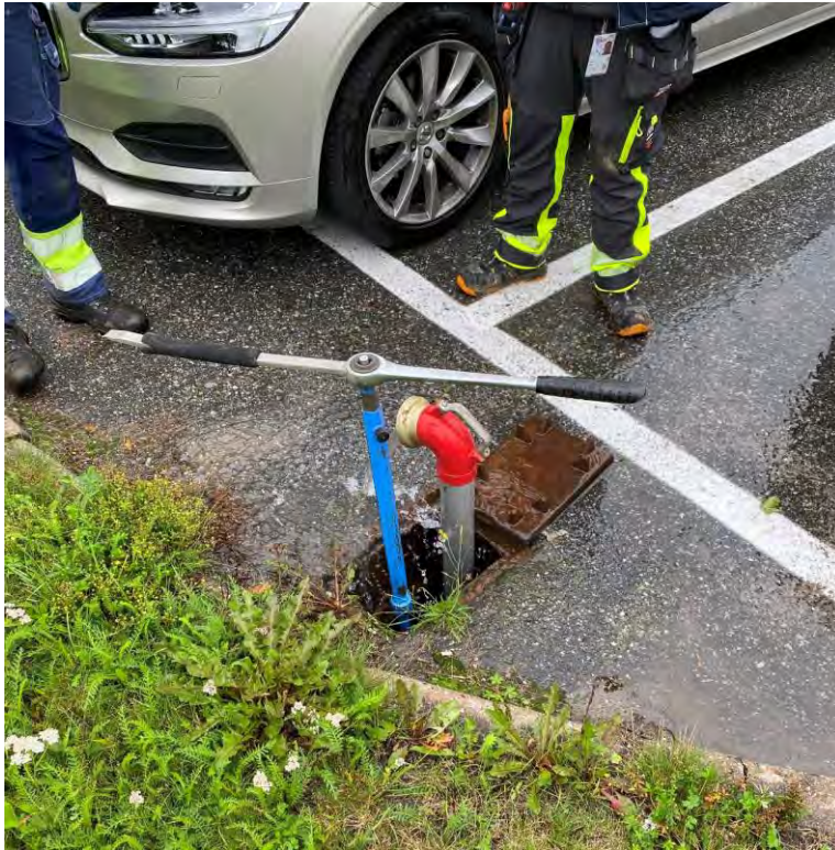
Bild 2. Spolning av brandpost (för att säkerställa en avstängning). Foto: Mikael Lindroos
