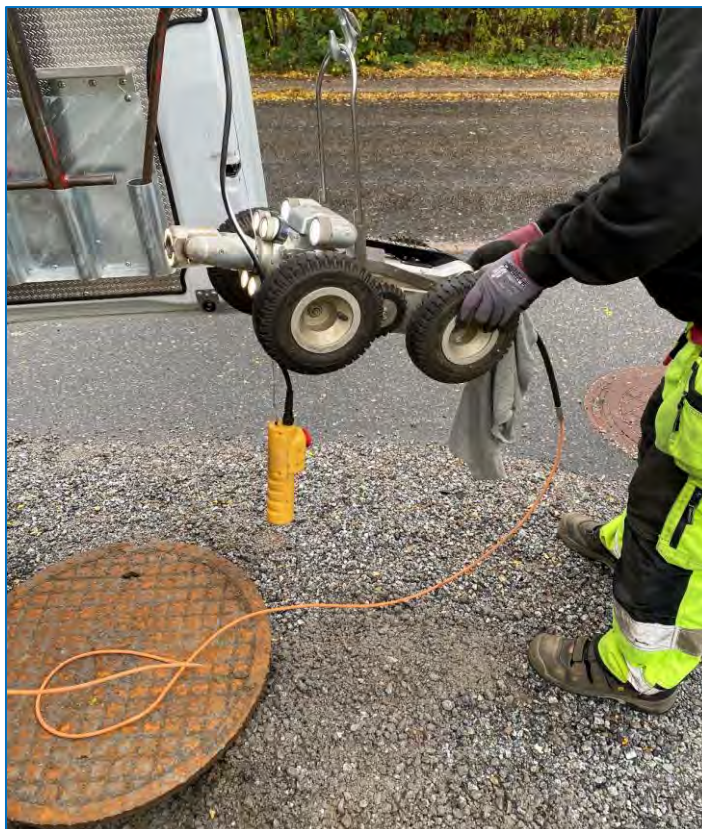
Bild 9. Filmning av spillvattenledning är en del av arbetet för framtagande av VAs förnyelseplan. Foto: Mikael Lindroos
