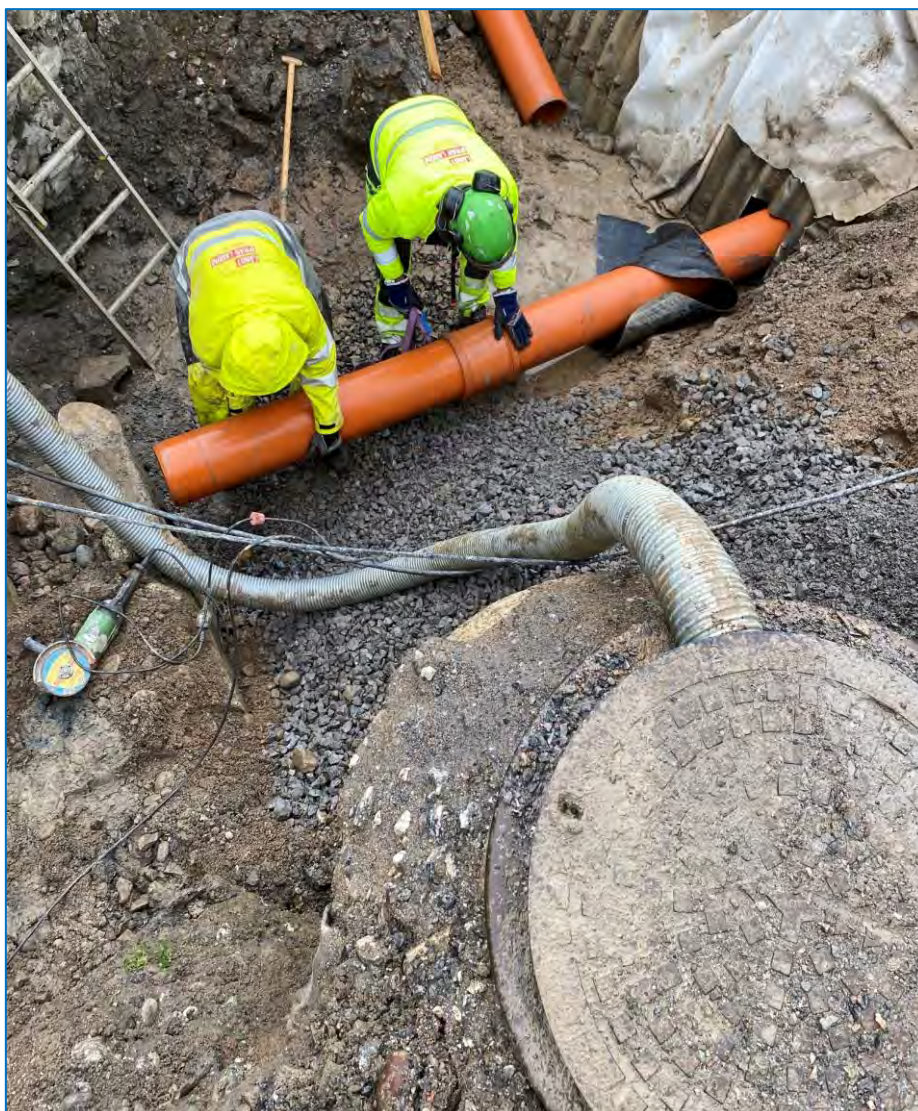
Bild 6. Reparation av en kollapsad dagvattenledning. Foto: Mikael Lindroos
