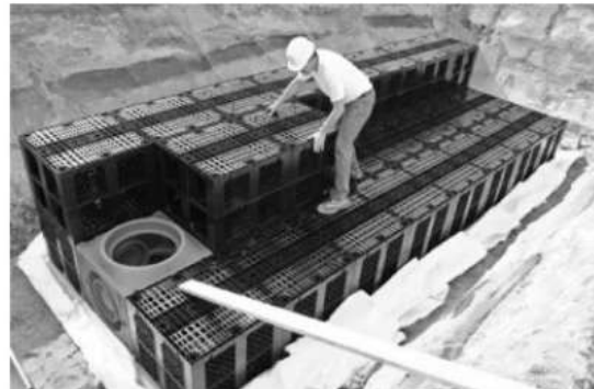
Figur 18: Typsektion krossfyllt magasin med överbyggnad, dagvattenkassetter.
