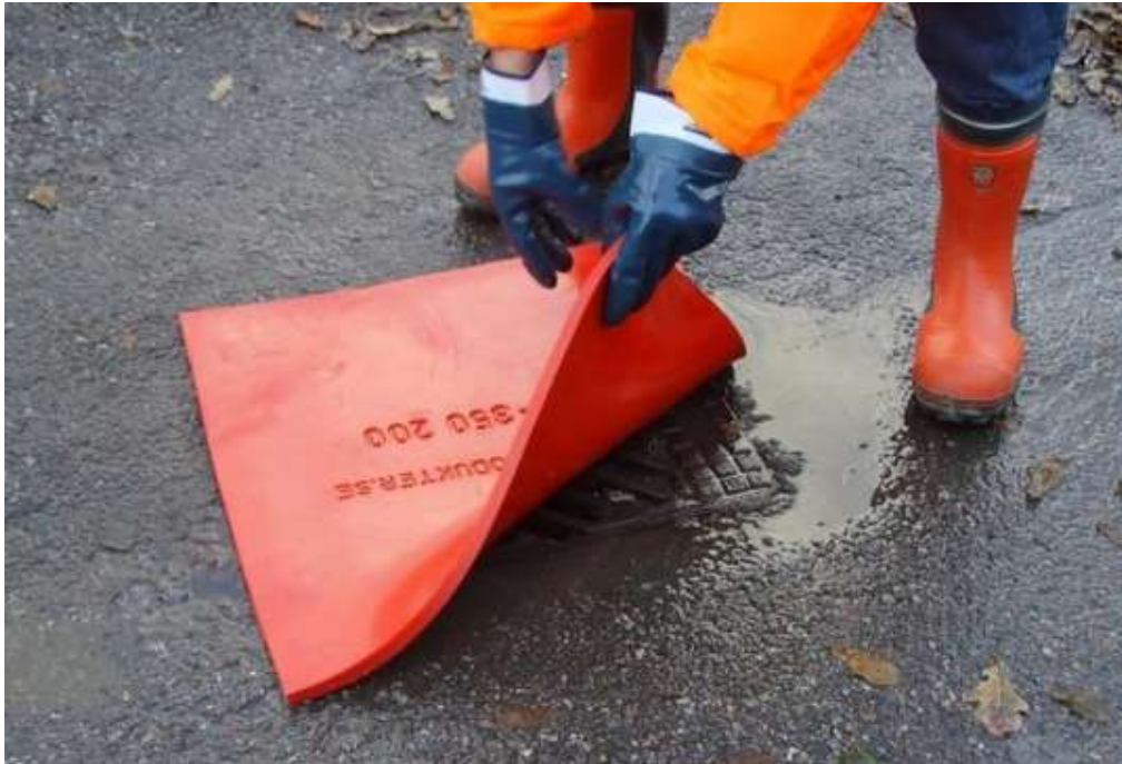
Figur 19 Exempel på brunnstättning med matta (Källa: med tillåtelse av (PK ProdukterAB, 2014))
