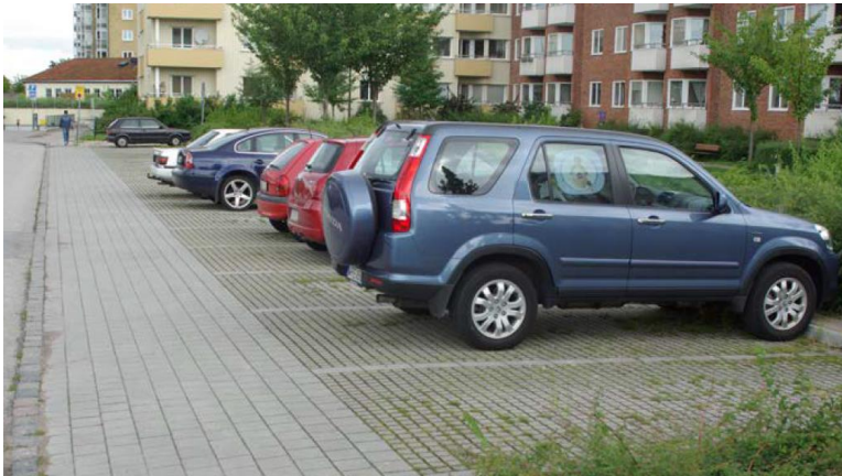
Figur 9. Exempel på genomsläpplig beläggning på parkeringsplats. 7
