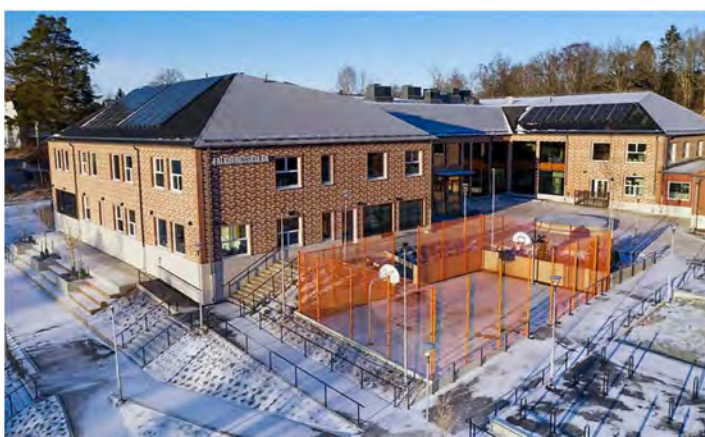
Ny- och ombyggda Falkbergsskolan i Tullinge Foto: Tol Arkitekter AB
