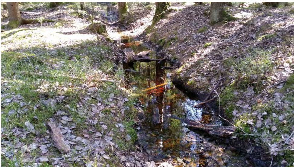
Dike i områdets södra del
