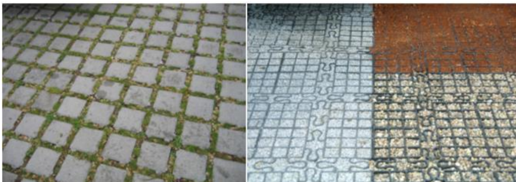
Figur 6: Genomsläppliga beläggningar. 6
