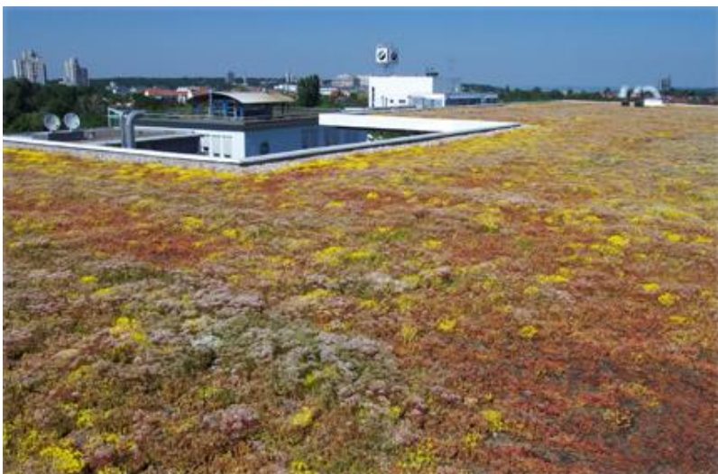
Figur 4: Grönt sedumtak 4 .
