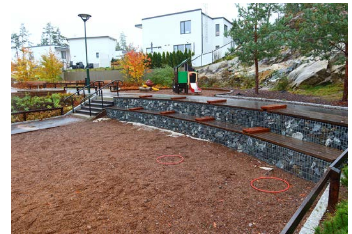
Gabionmur med sittplatser.
