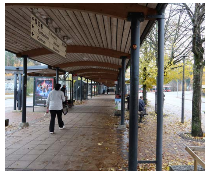
Bussterminalen med det stora skärmtaket.
