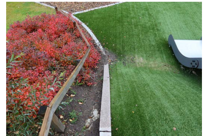
Erosion med materialspridning från plantering över konstgräsytan.
