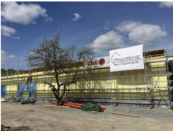
Fasad hus C mot Pressbyrån
