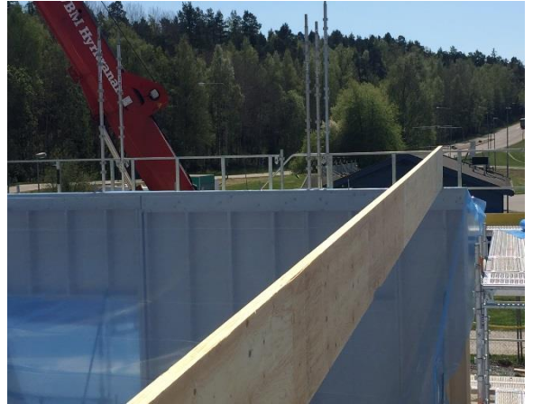
Montage takstolar hus C
