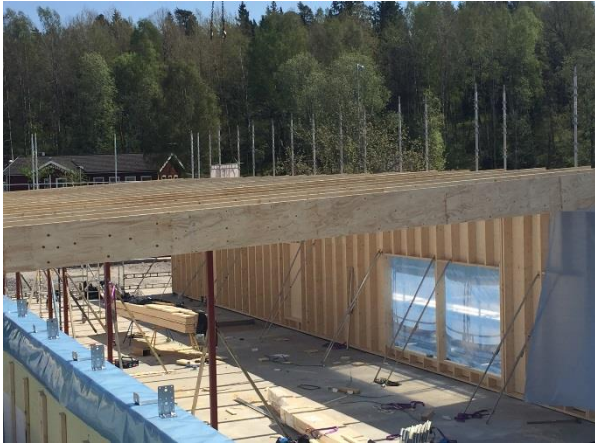
Montage takstolar hus C
