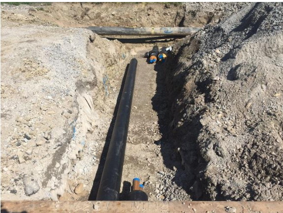
Schakt för dag- och spillvatten
