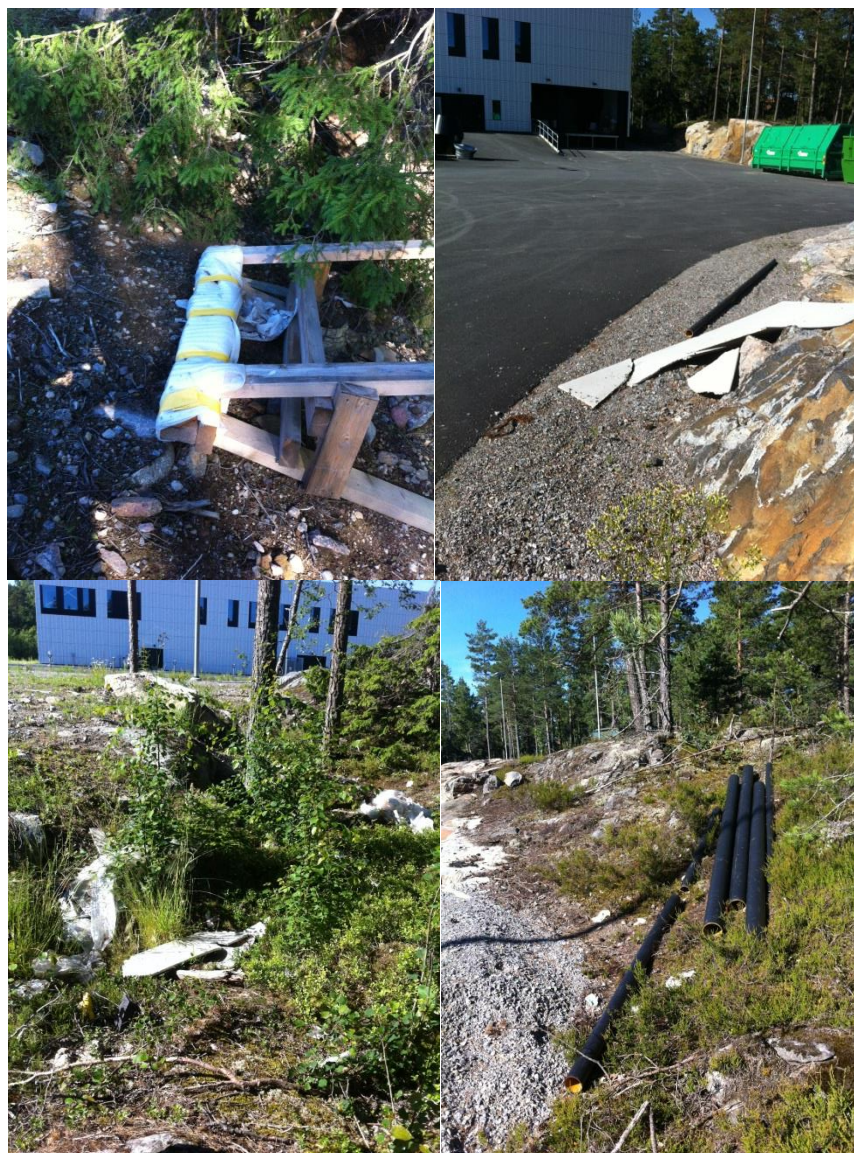
Fig. 4-7: Foton från planområdet i angränsning till befintlig byggnad
