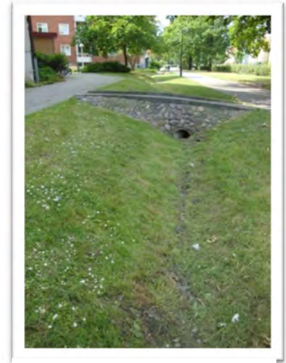
Bild 10. Principbild på skåldike
