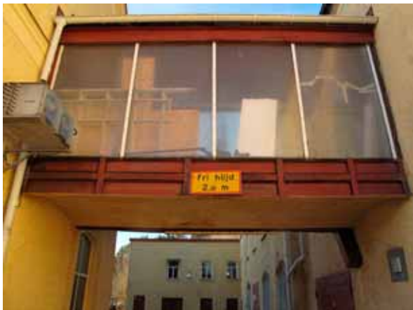
Tv. Bro mellan kraftstation och ekonomibyggnad konstruerad med välvt bjälklag i järn och betong. Th. Transformatorstationen från sydväst. Lp 20110132 och Lp20110108.
