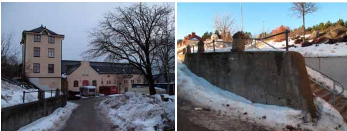
Vägstråk från övre området n2 till gårdsplanen framför ladugården. Gaturummet inramas med för området typiska inslag stödmur av betong med smidesstaket och pelare samt träd som troligtvis ingått i en anlagd trädrad. Th Möte mellan en äldre stödmur och en nyare trappa. Lp20110124 och Lp 20110125.
