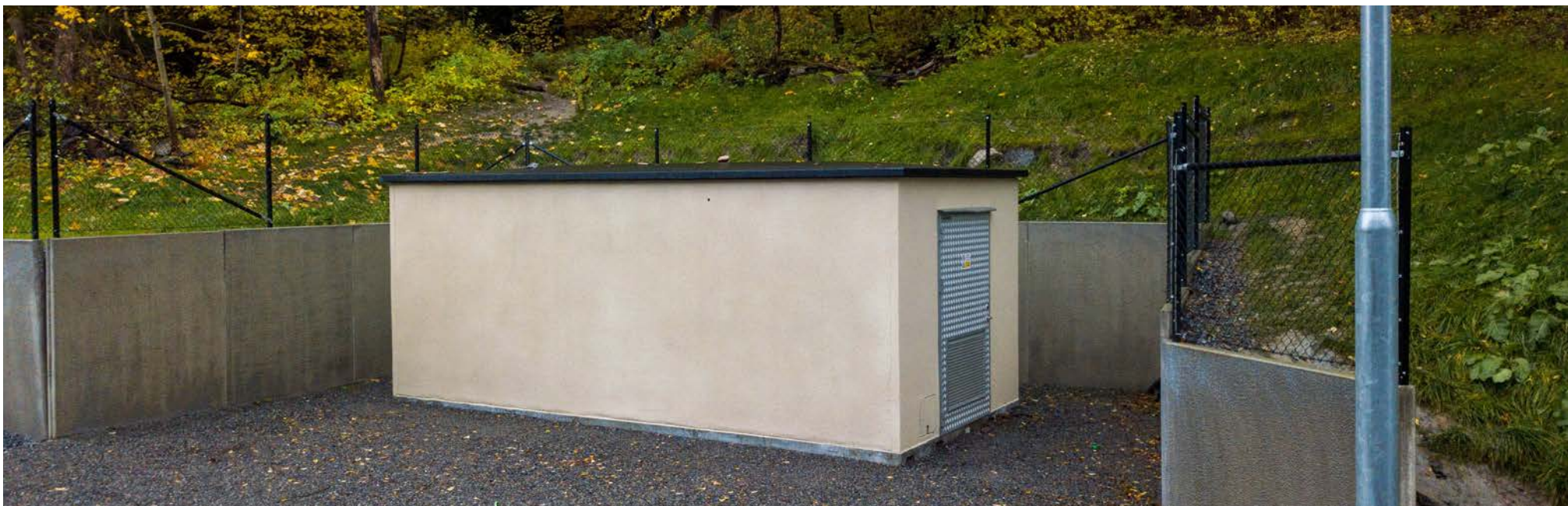
Befintlig nätstation vid Bryggarvägen
