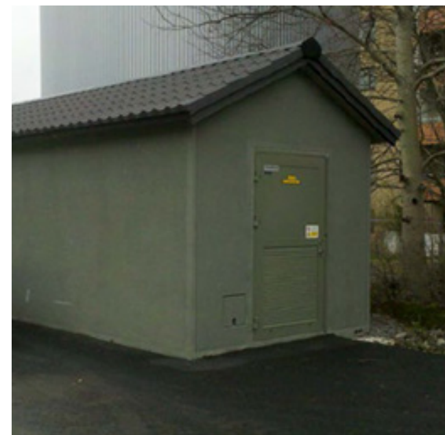
Referens för nätstation i Standardutförande B2 Special med sadeltak, Vattenfall
