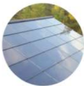
EXTERIÖR. Tak med integrerade solceller.
