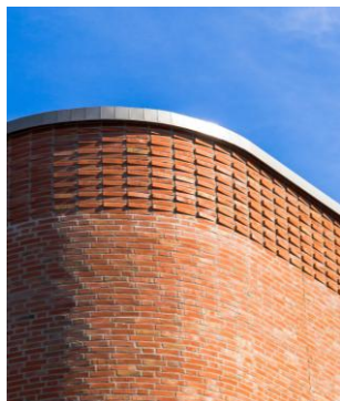
Byggnadsdetalj på Eleonoraskolan, Hallunda Foto: Andreas Korsfeldt af Trolle
